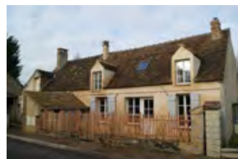
Facade rue (après)
